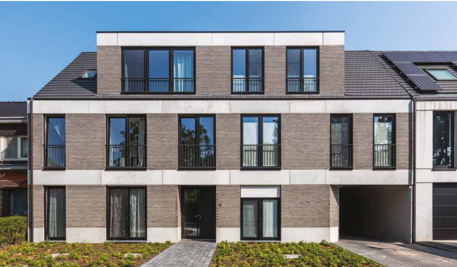
Architect De Beenhouwer - Léonard Architecten, Antwerpen
